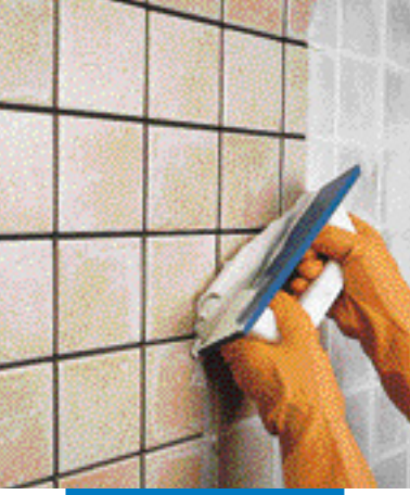
Tek pişirimli karolarla kaplı bir duvarın derz dolgusunun kauçuk mala ile yapılması
