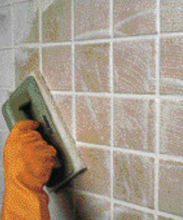
Tek pişirimli karolarla kaplı bir duvarın Scotch-Brite® pad ile bitirilmesi
